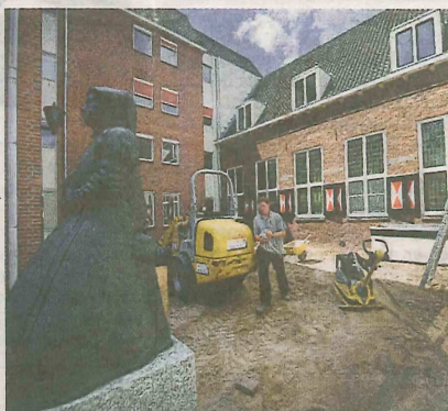
Bouwwerkers zijn bezig op het binnenplein van het Bartholomeus Gasthuis.
